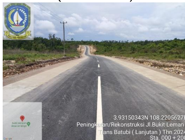
Gambar 3.20 Peningkatan/Rekonstruksi Jalan Bukit Leman - Trans Batubi Lanjutan, Kab. Natuna (DAK - Tematik 01)
