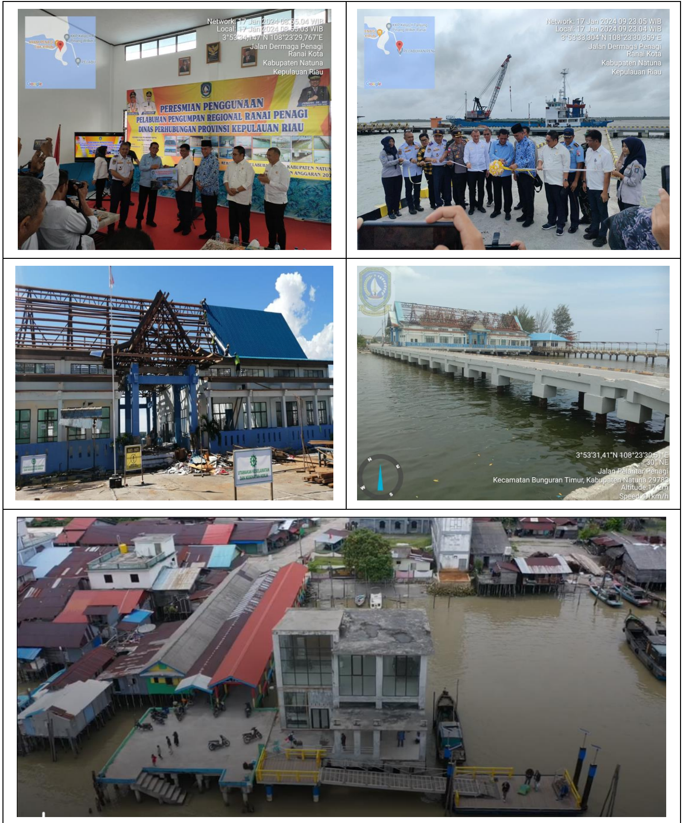
Gambar 3.18 Dokumentasi Pembangunan Pelabuhan
