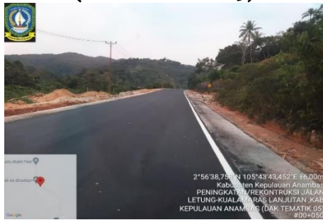
Gambar 3.21 Peningkatan/Rekonstruksi Jalan Letung - Kuala Maras Lanjutan, Kab. Kepulauan Anambas (DAK - Tematik 05)
