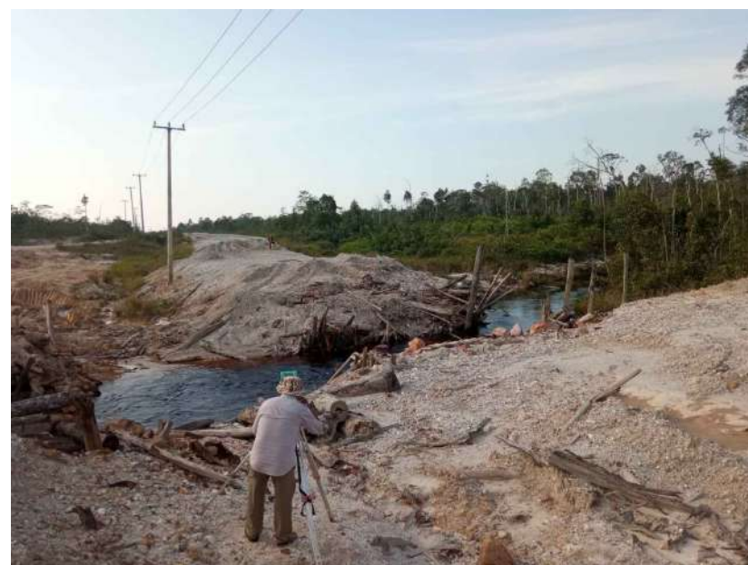
KONDISI JEMBRAN EKSISTING
